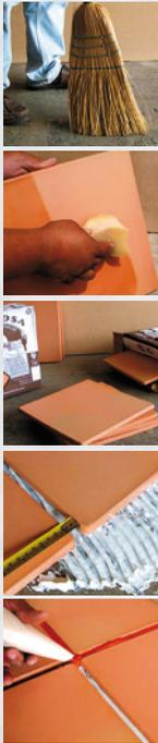
**1. Limpieza;** el firme donde se instalará la baldosa deberá estar nivelado totalmente limpio y libre de humedad.
