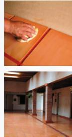
**6. Acabado final;** una vez instalada la baldosa aplique nuevamente el sellador de su elección. Es de suma importancia no saturar el piso con agua durante la limpieza o dañara el sellador aplicado. Asegúrese de resanar y sellar perfectamente las boquillas para evitar filtraciones de humedad.
